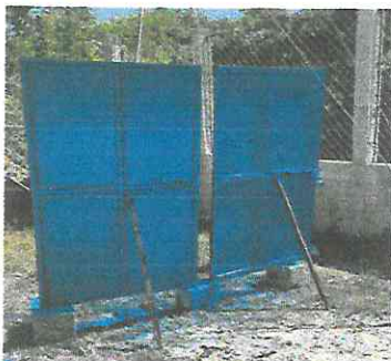
Foto 11: Se están lijando, puliendo y pintando las puertas de los sanitarios.
