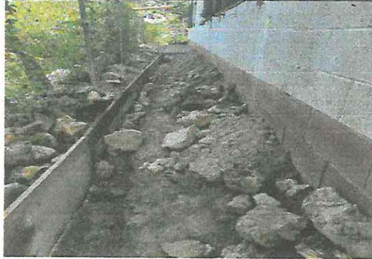
Foto 7: Se está instalando una banqueta de concreto alrededor de las aulas 1 y 2.
