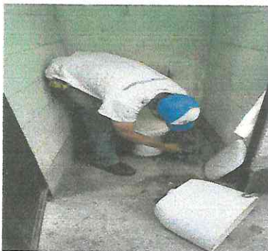
Foto 9: Se está sustituyendo el sanitario 2.
