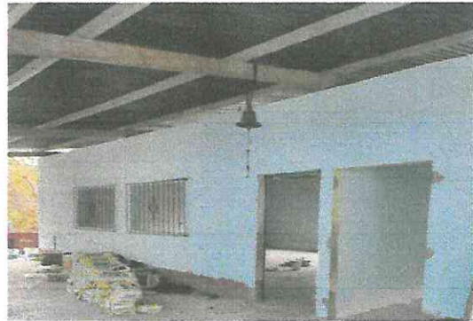
Foto 2: En el Aula 1, se está renovando la pintura de los muros exteriores y se están instalando ventanas de PVC con vidrio.
