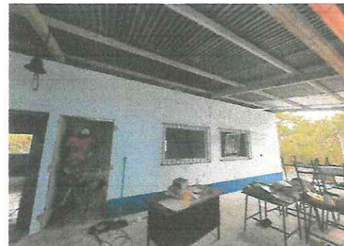
Foto 4: Se observa el lado exterior del Aula 2, donde se están pintando los muros y se están instalando ventanas de PVC con vidrio.
