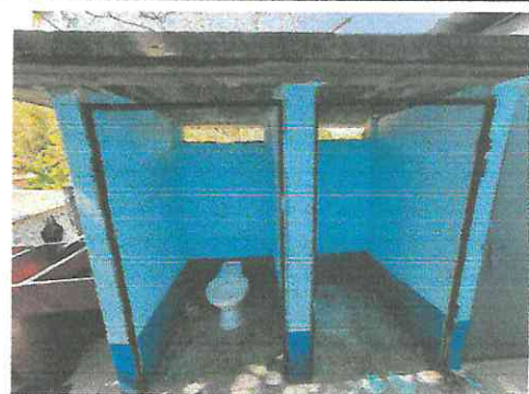
Foto 10: Se están pintando los muros exteriores de los baños.
