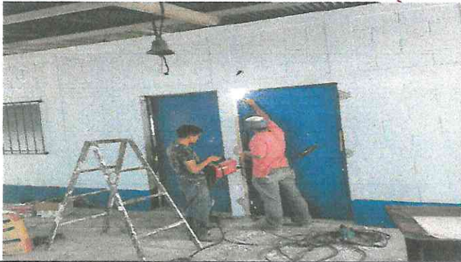
Foto1: Las puertas están siendo lijadas y pintadas. Asimismo, se están reforzando los marcos y se están instalando las chapas.
