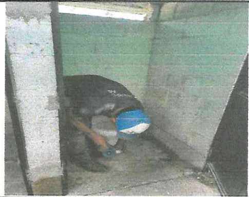
Foto 8: Se está sustituyendo el sanitario 1
