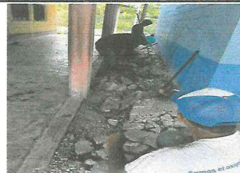
Foto 6: Se está instalando una banquetta de concreto a lo largo del corredor.
