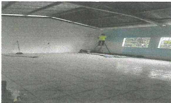
Foto 3: En el interior del Aula 1, se está sustituyendo el piso de cemento por cerámico, los muros están siendo repellados y pintados.
